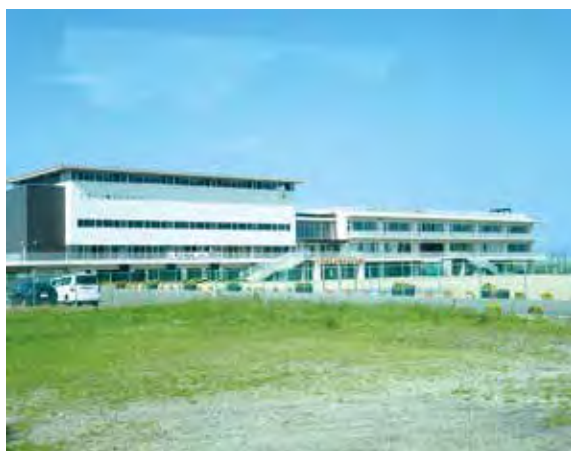
▲2階以上に教室を設置した亘理町立荒浜中学校
