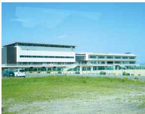
▲2階以上に教室を設置した亶理町立荒浜中学校
