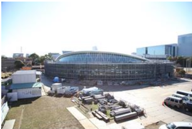
▲建設中の新英語学習施設「KUIS8」
